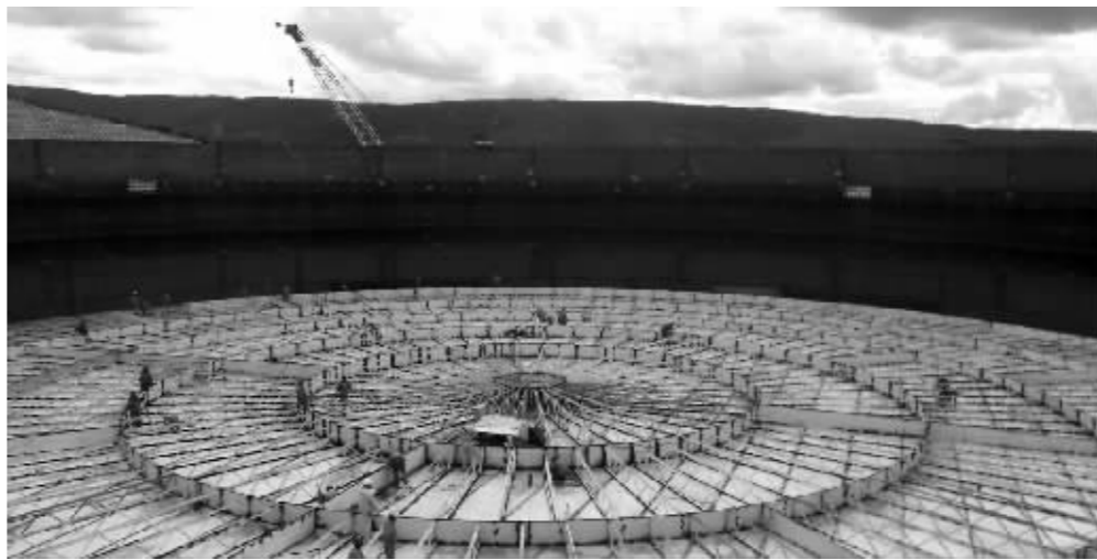
图为施工人员正在抓紧铺设10万立方米罐底板
