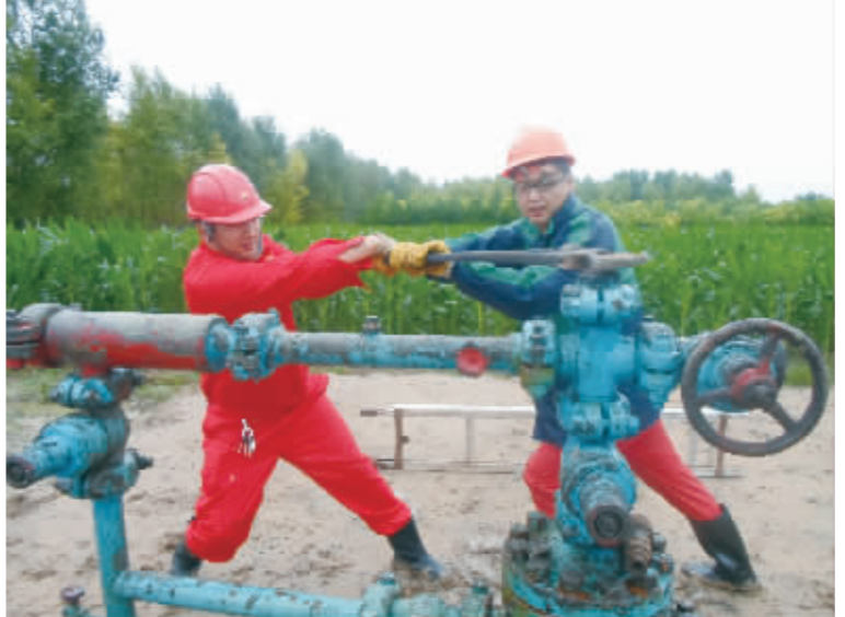
试井队员工正在拆卸水井测试堵头
