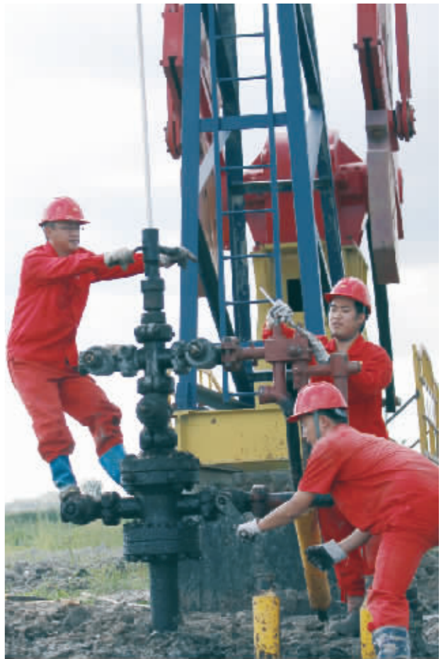
投产人员正在紧固盘根
