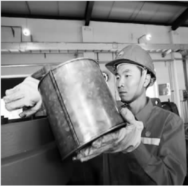
图为彭玉闯在给外输泵更换滤网
