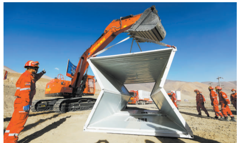
工作人员在西藏日喀则市定日县长所乡嘎旦村搭建板房。 新华社记者 沈伯韩摄
