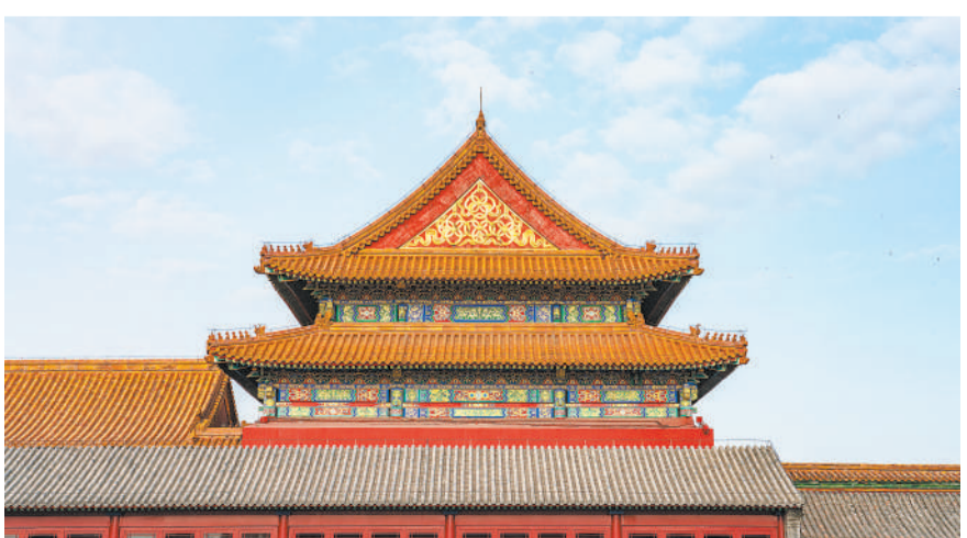
北京故宫宫殿建筑屋顶琉璃瓦。视觉中国供图
