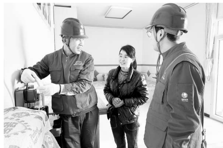
国家电网青海电力三江源(海东民和)共产党员服务队成员在为安置点住户检查用电安全。 王惠忠摄
