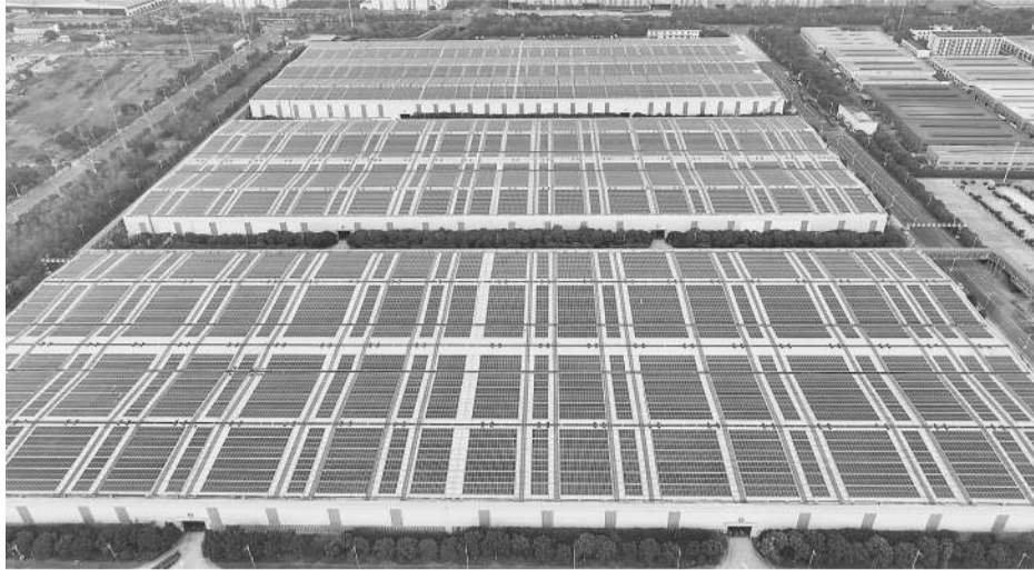
图为江苏省张家港市的屋顶分布式光伏发电项目。 施柏荣/视觉中国
