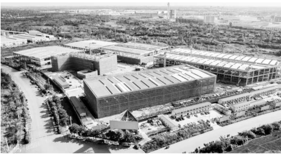
成都淮州新城低碳环保科技园项目现场。
