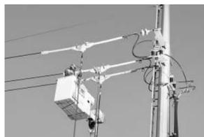
图为工作人员正在对中压发车间旁路电缆与10千伏架空线路进行带电连接作业。胡迩瀚摄
