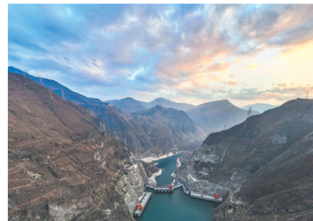
图为乌东德水电站一景。新华社记者 胡超摄
