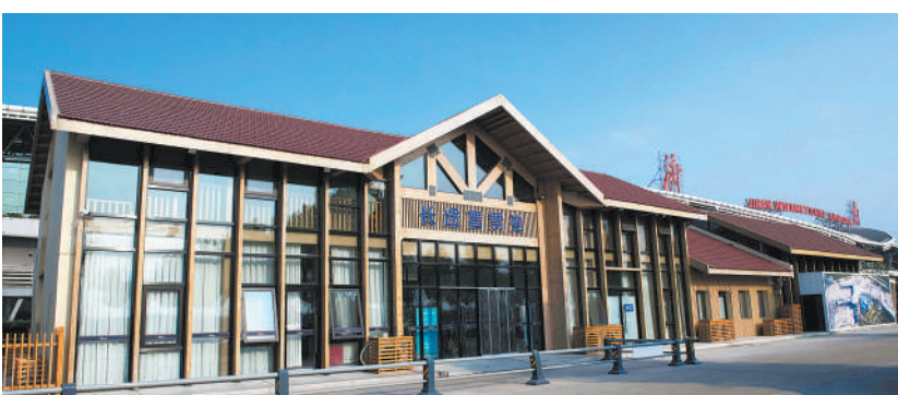
用无机胶复合竹材料建成的济南国际机场客运站。受访单位供图
