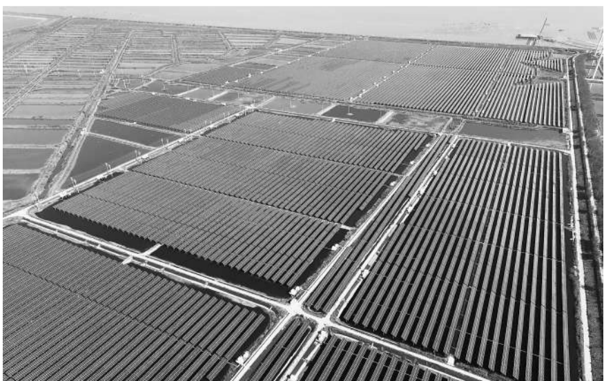
图为位于江苏省南通市如东县的光伏发电项目。新华社记者 丁汀摄
