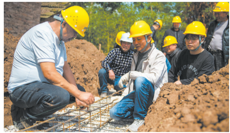
在湖南省常德市安乡县一建筑工地，技师（左一）向工人们讲解扎筋技巧。新华社记者 周勉摄
