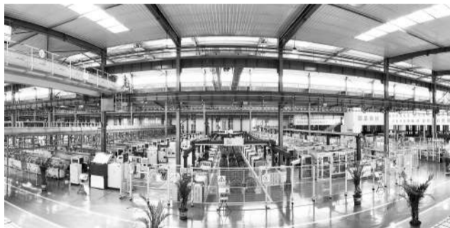
图为位于吕梁市的中阳钢铁有限公司焊丝生产线。贺双泉摄
