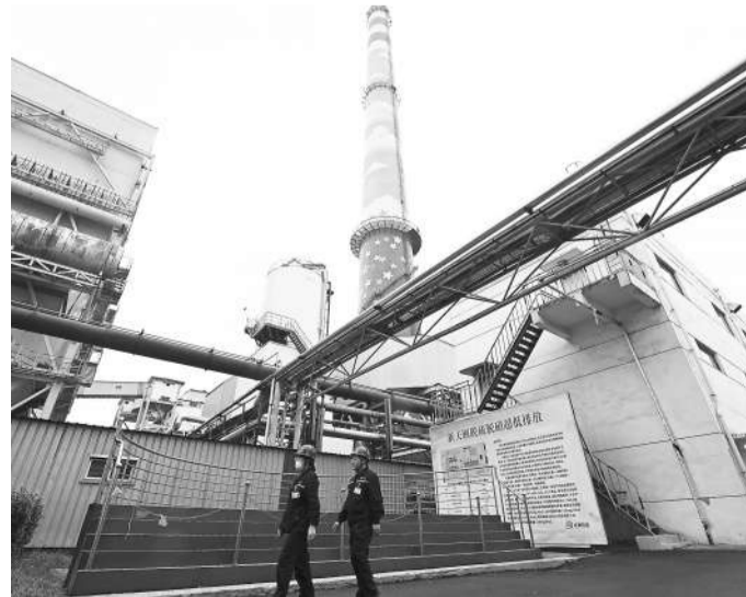
图为天津市新天钢铁集团有限公司烧结烟气脱硫脱硝项目。新华社记者 赵子硕摄
