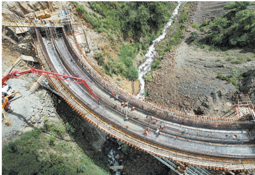
马丘比丘公路施工现场。
