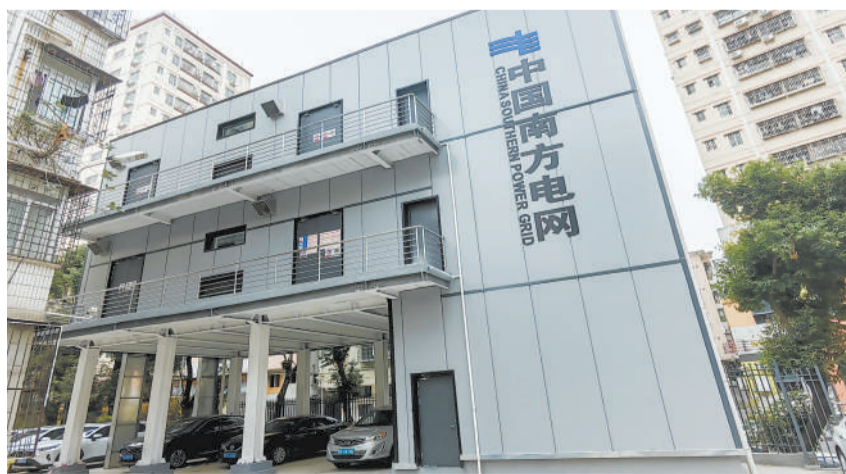
大发埔村在居民停车位上新建三层建筑,既保留居民停车位,又使电力设施在二、三楼有了科学布局。 余郁彬摄
