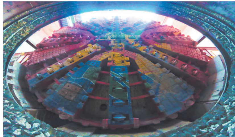
“羊城号”开始掘进。 张玺摄
