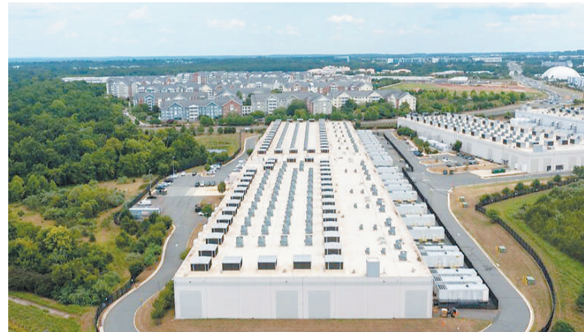
亚马逊数据中心。
