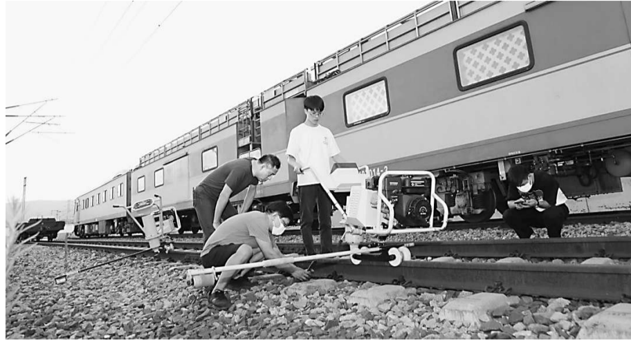
重庆电子工程职业学院师生正在使用轨枕螺栓高精度智能检测与检修设备进行现场勘测。 受访者供图
