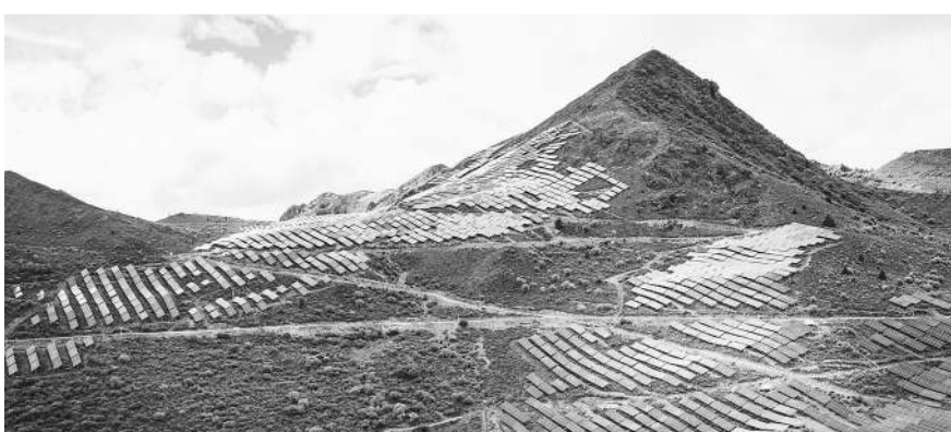
图为四川凉山立洲水电站“水光互补”让白光伏项目。 受访单位供图
