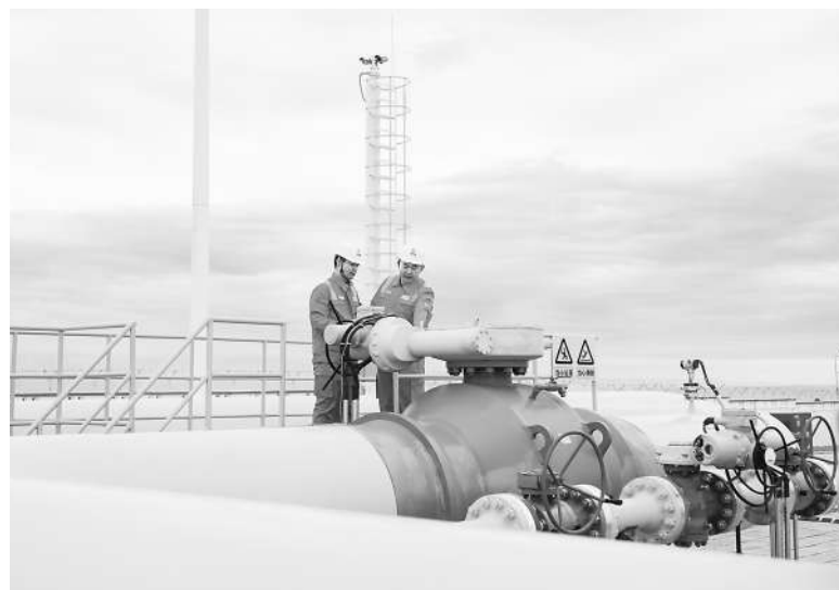
工作人员在西气东输四线吐鲁番站进行投产前检查。
