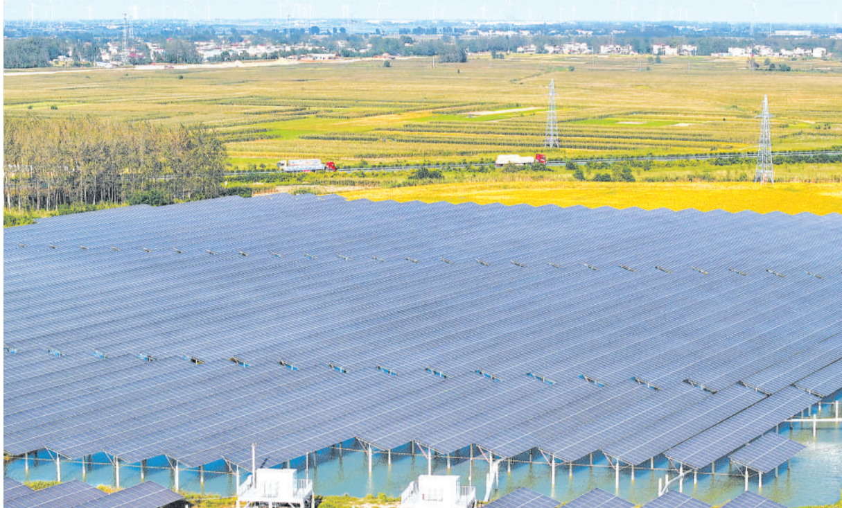
位于安徽省蚌埠市五河县的光伏发电设施。
