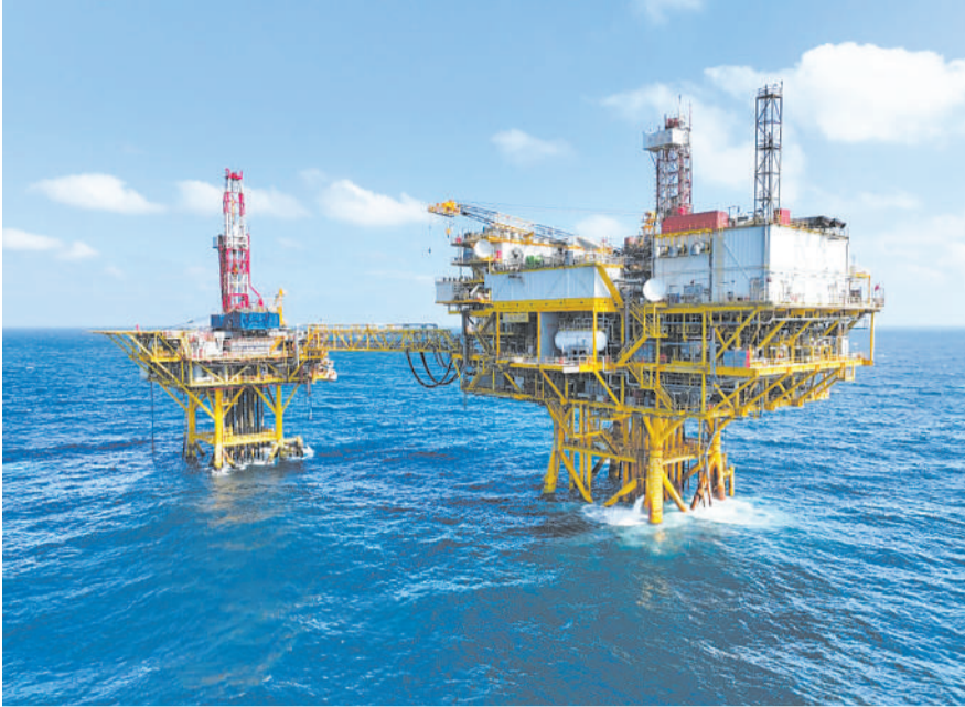
可控轨迹超短半径多分支井技术在文昌海域应用。
