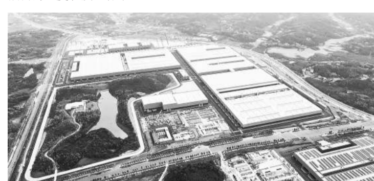
图为中联智慧产业城起重机械园中的室外新能源整车试车跑道。 受访者供图
