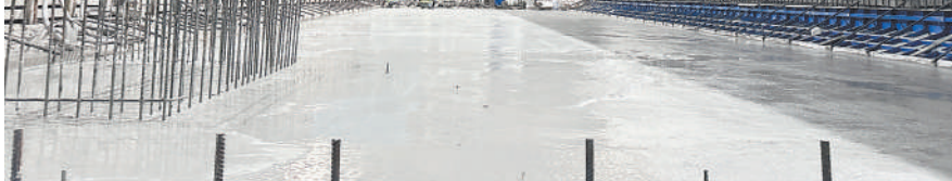
应用饰面高性能混凝土的施工现场。受访单位供图
