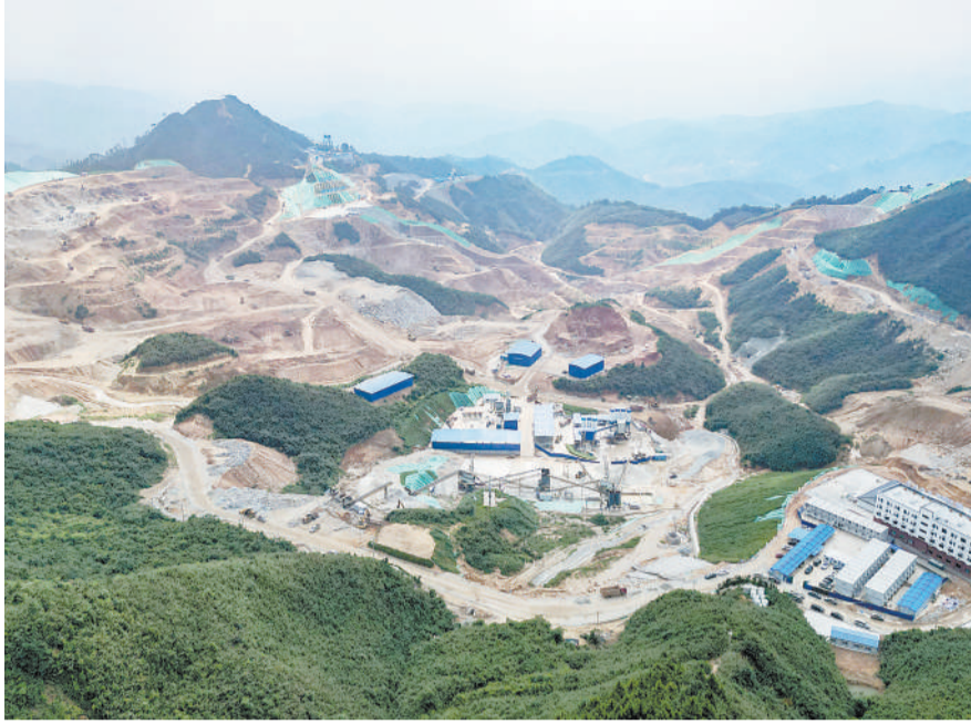
建设中的肇庆浪江抽水蓄能电站。受访单位供图
