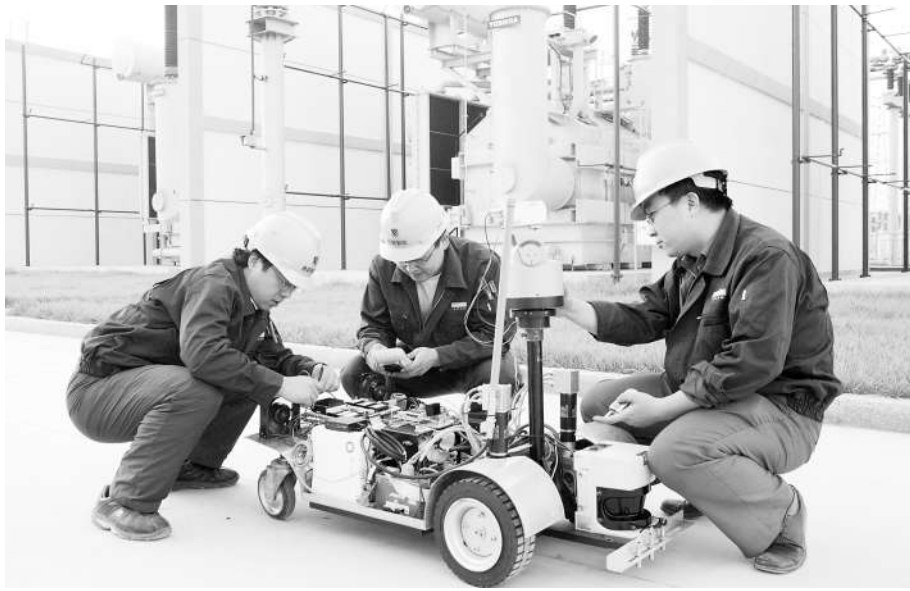
图为国网智能科技股份有限公司研发工程师在变电站现场对变电站巡检机器人进行测试。 孙志周摄
