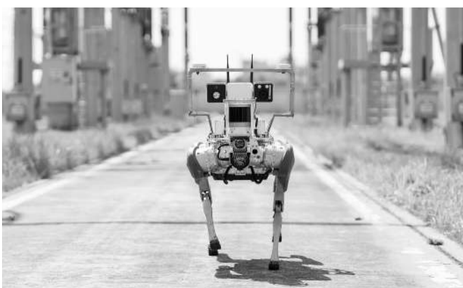
在南京500千伏东善桥变电站,新型巡检机器人开展巡视工作。 杜懿/视觉中国
