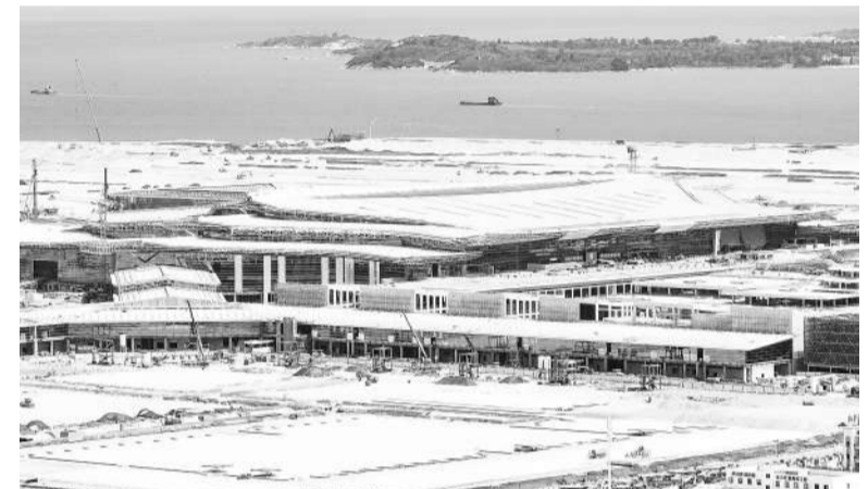
图为正在施工的厦门翔安机场。
