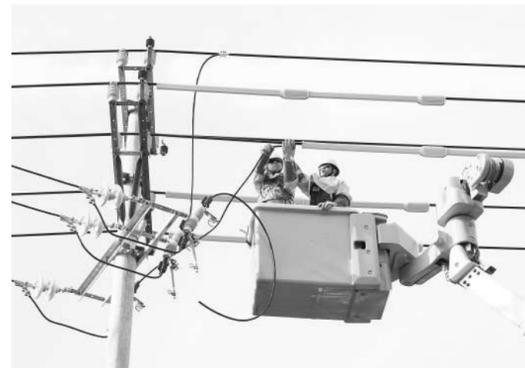
日前,在浙江省诸暨市大唐街道骆家村,国网诸暨市供电公司带电作业人员穿着厚重的绝缘服,乘坐绝缘斗臂车升至10米高空,为10千伏线路U477线路4号杆开展隐患治理工作。图为作业人员更换绝缘引流线,为导线安装遮蔽罩,确保设备在大负荷下处于最佳运行状态。
