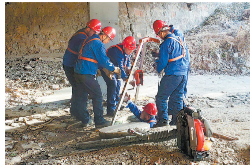
山西省阳泉市热力公司专业技术人员准备下井对热网管设备进行检查。新华社记者 魏晓霞
