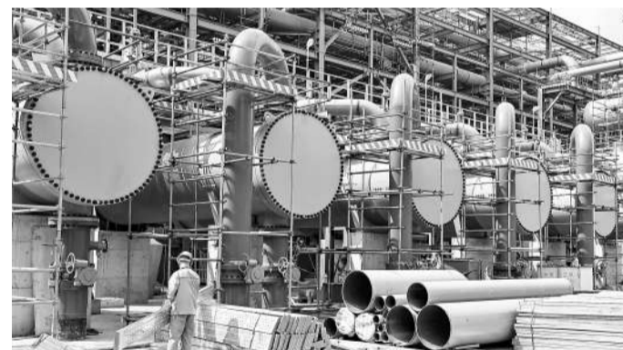
图为吉林石化炼油化工转型升级项目120万吨/年乙烯装置施工建设现场。新华社记者 颜麟蕴摄
