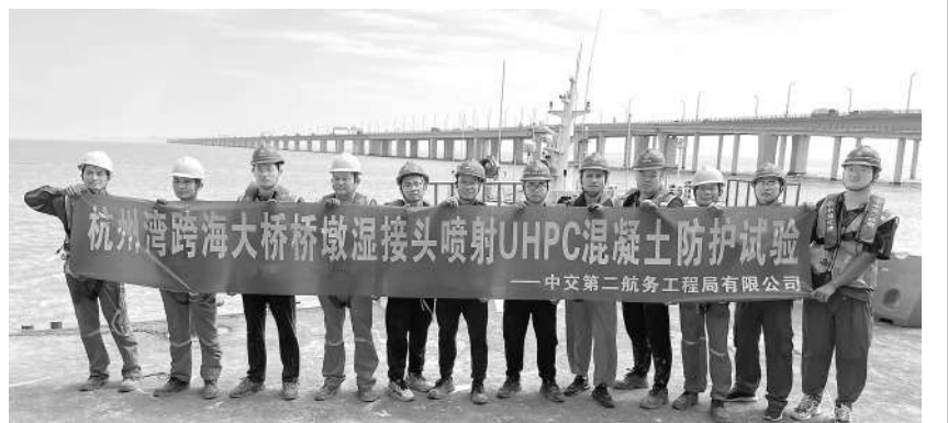
中交二航局技术人员在杭州湾跨海大桥施工现场。
