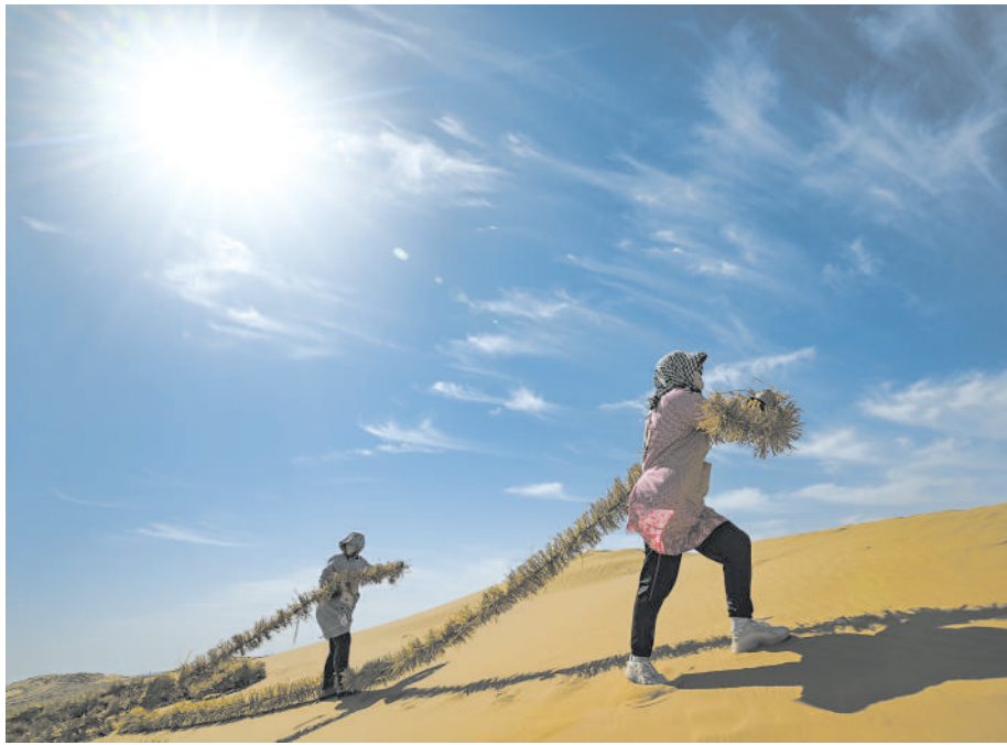
治沙工人在宁夏中卫市境内的腾格里沙漠铺设刷状网绳式草方格沙障。
