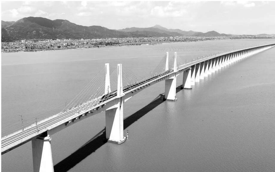
一列复兴号智能配置动车组驶过福厦高铁湄洲湾跨海大桥。福厦高铁配备的大跨桥梁与轨道一体化健康监测系统能够精准捕捉轨道结构应变、动挠度等数据发生的细微变化。
