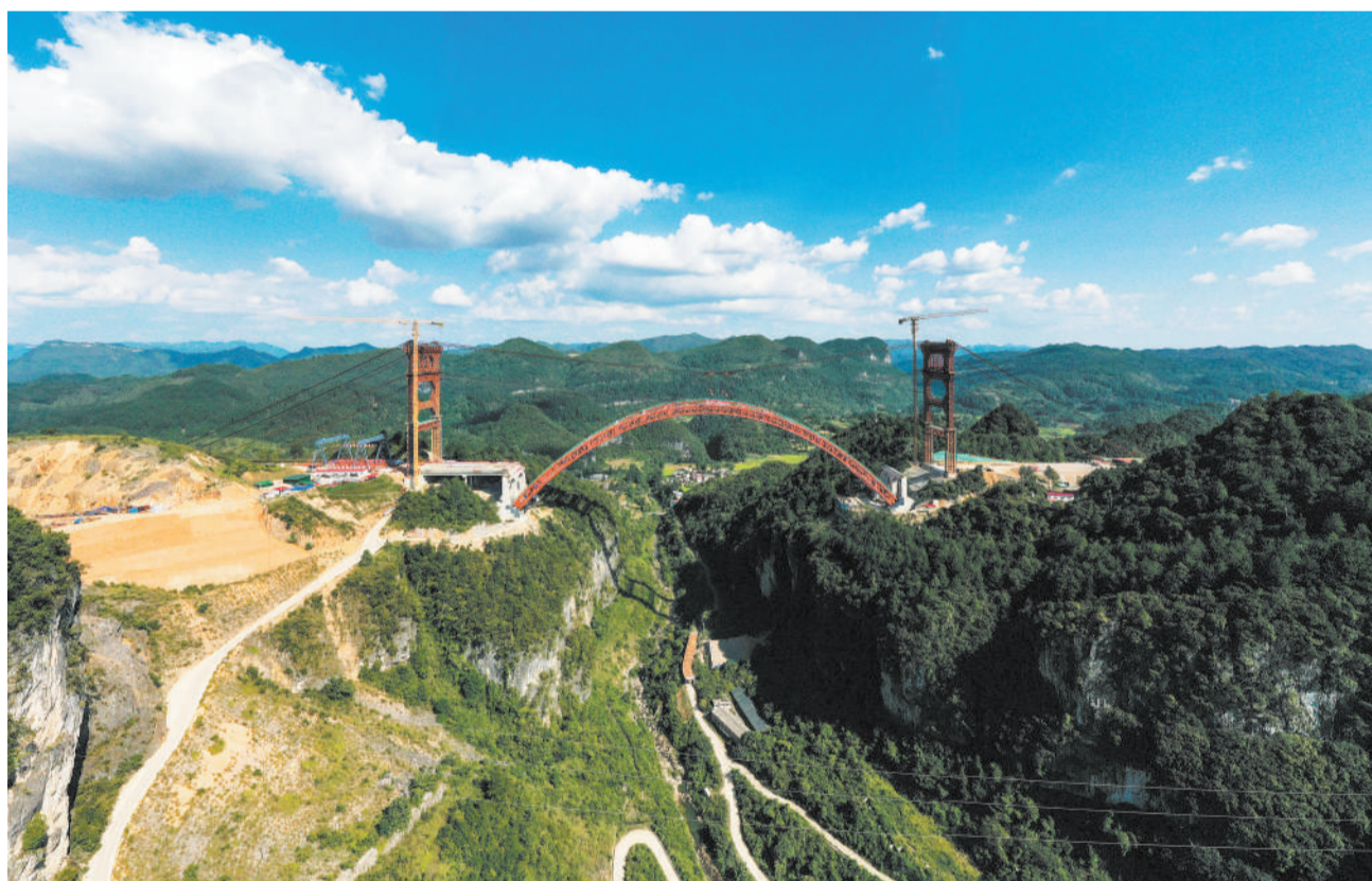
8月21日，由贵州桥梁集团承建的贵阳至平塘高速公路马场河特大桥主拱顺利合龙。马场河特大桥位于贵州省贵定县盘江镇马场河村，大桥全长381.5米，主跨260米，是G7522贵阳至北海高速公路贵阳至平塘段控制性工程。图为8月21日拍摄的马场河特大桥施工现场(无人机照片)。
