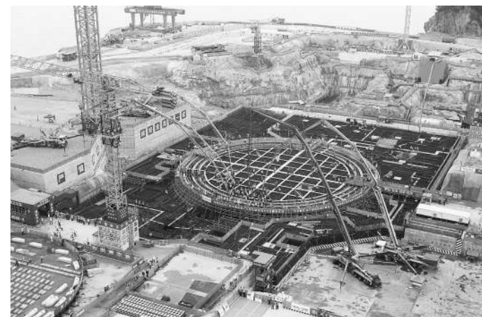
中广核福建宁德核电站5号机组主体工程施工现场。 中广核供图
