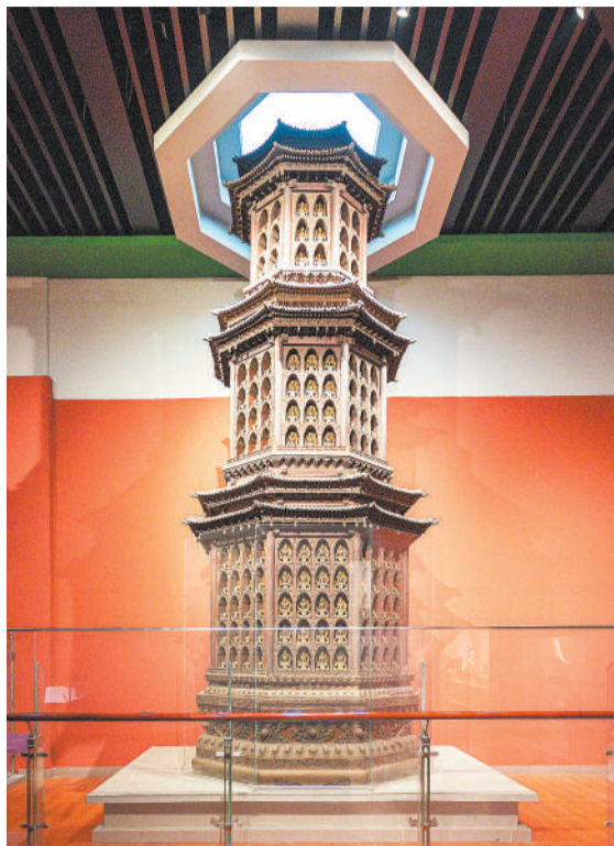
洛阳博物馆官廷文物馆展示的三层金丝楠木塔，整座佛塔全部采用榫卯工艺。视觉中国供图
