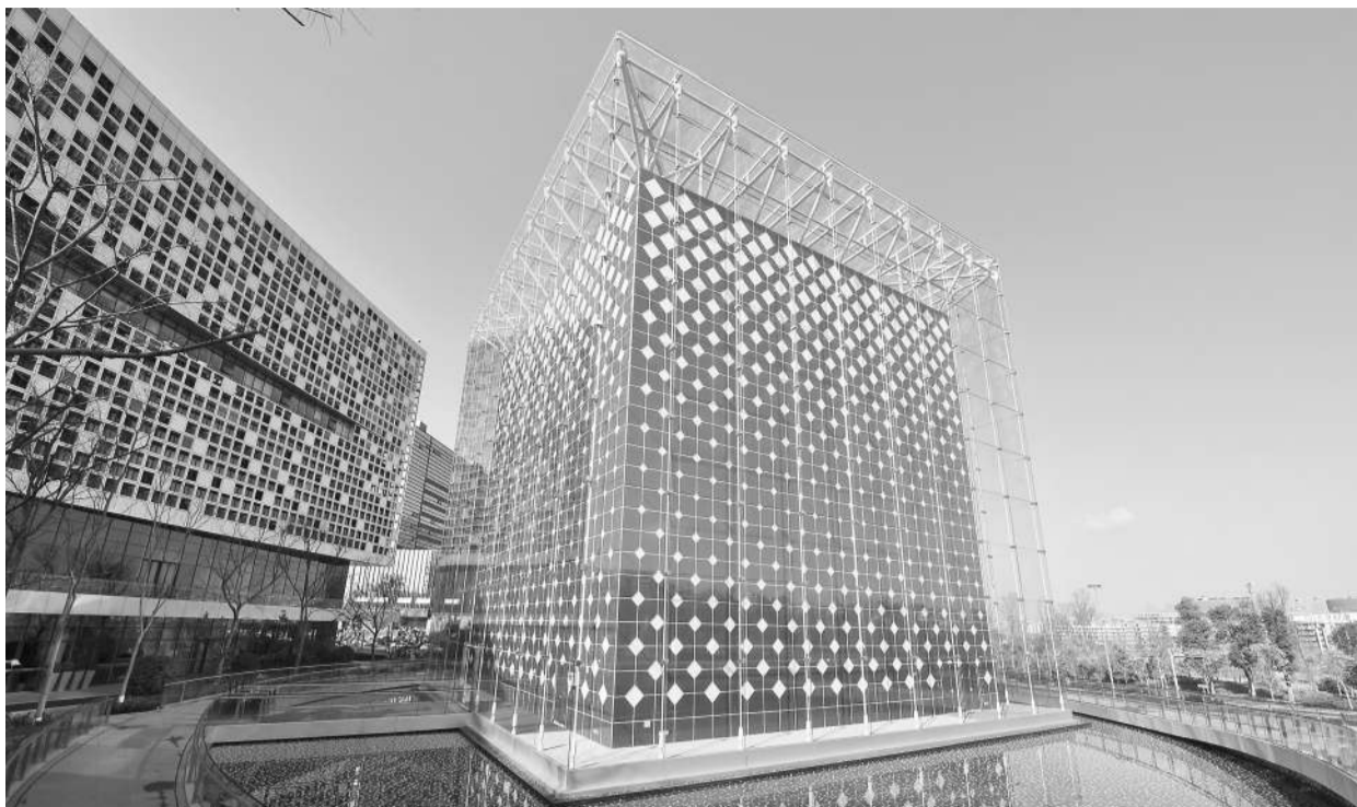
图为国家级计算成都中心主机房“硅立方”。
