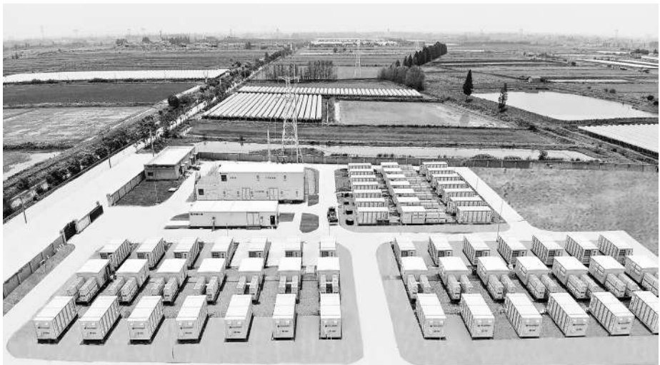
图为大唐钠离子储能项目现场。
