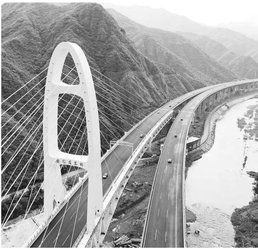
7月1日,京蔚高速北京段(西六环—灵山互通立交)正式通车。从北京西六环军庄立交驾车至灵山,由2小时缩短至45分钟。图为京蔚高速北京段(无人机照片)。
