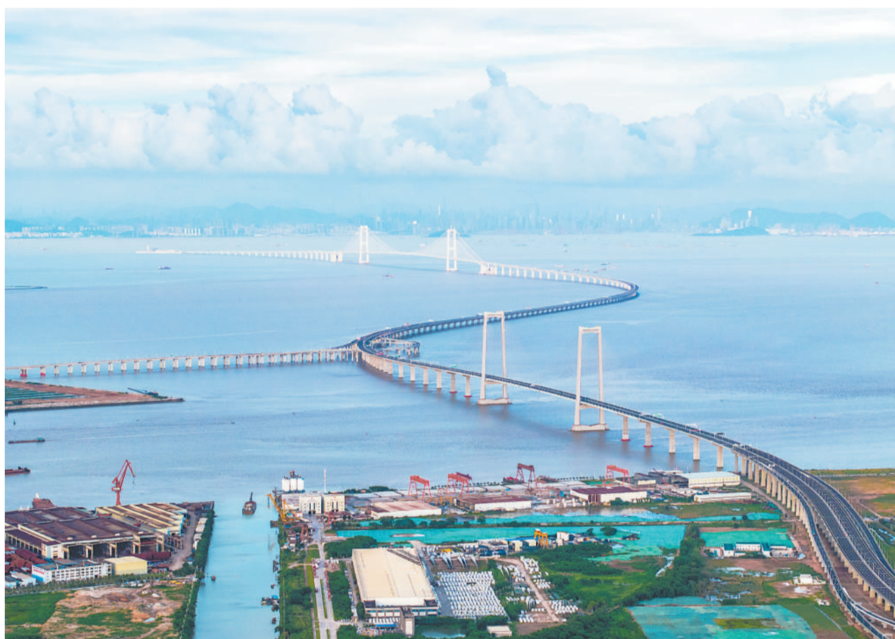
6月30日，历时七年建设的国家重大工程深中通道正式通车试运营，从深圳到中山的车程从原来的2小时缩短至30分钟。深中通道是环珠江口“A”字形交通网络骨架的关键“一横”，跨越伶仃洋，让“深莞惠”与“珠中江”两大城市群实现了跨海直连。深中通道全长约24公里，集“桥、岛、隧、水下互通”于一体，是世界上综合建设难度最高的跨海集群工程之一。图为6月27日拍摄的深中通道全景。
