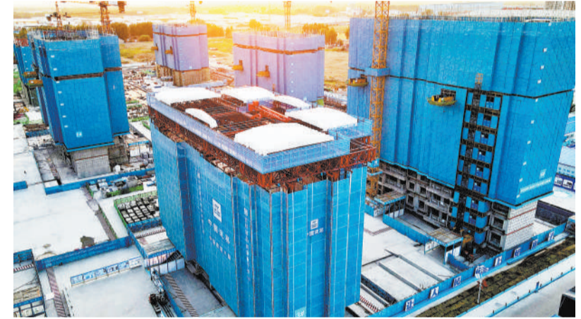
“天蝉”住宅施工机器人系统在青岛胶州市黄埠岭片区棚户区改造项目中投入使用。 李源摄
