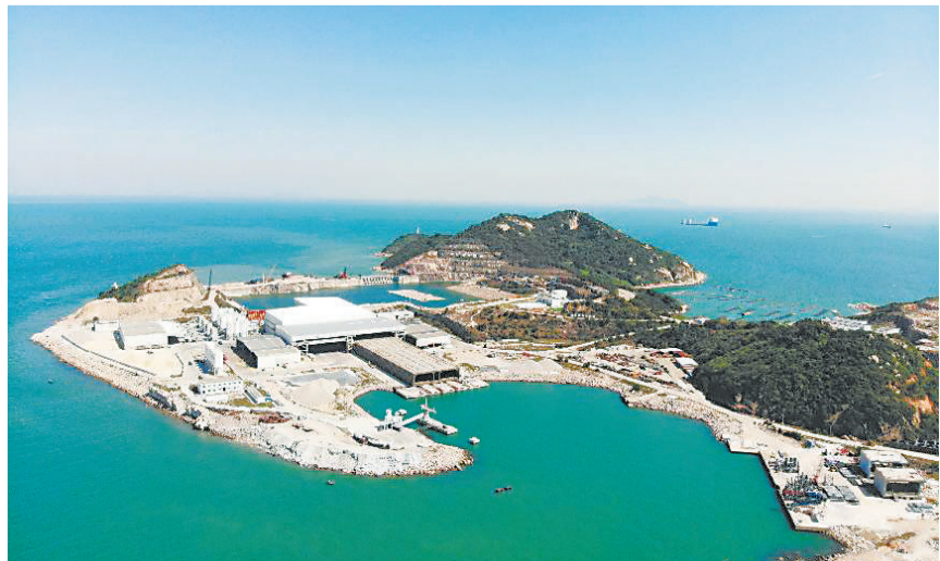
图为深中通道沉管智慧预制厂。 受访单位供图
