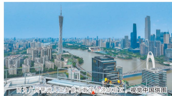
图为广州粤港澳大湾区人工智能与数字经济试验区。视觉中国供图
