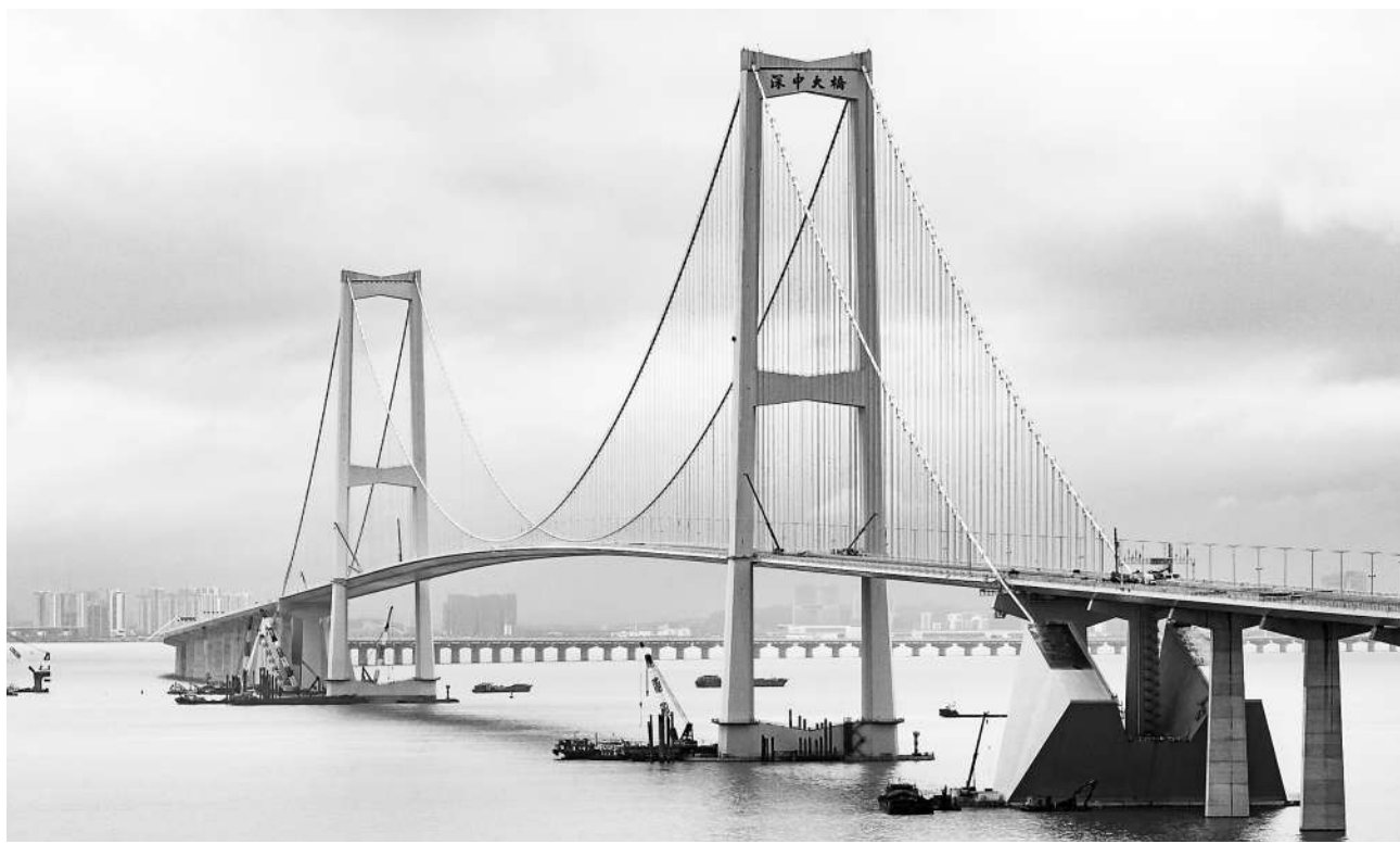
图为深中大桥(原名伶仃洋大桥)。
