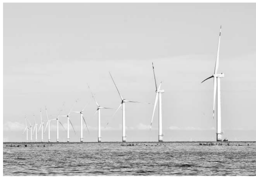
辽宁大连庄河海上风电项目。
