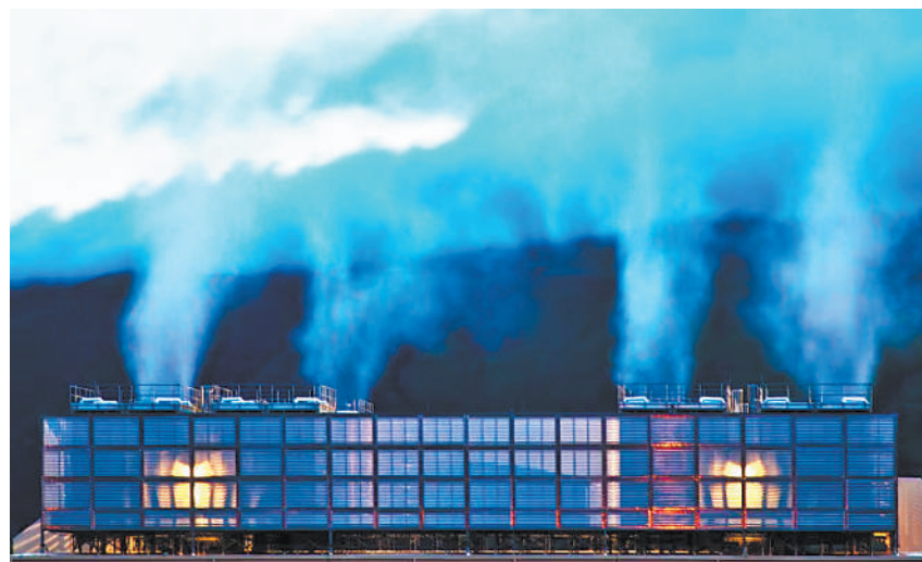
谷歌位于俄勒冈州达尔斯的超级数据中心冒出蒸汽柱。
