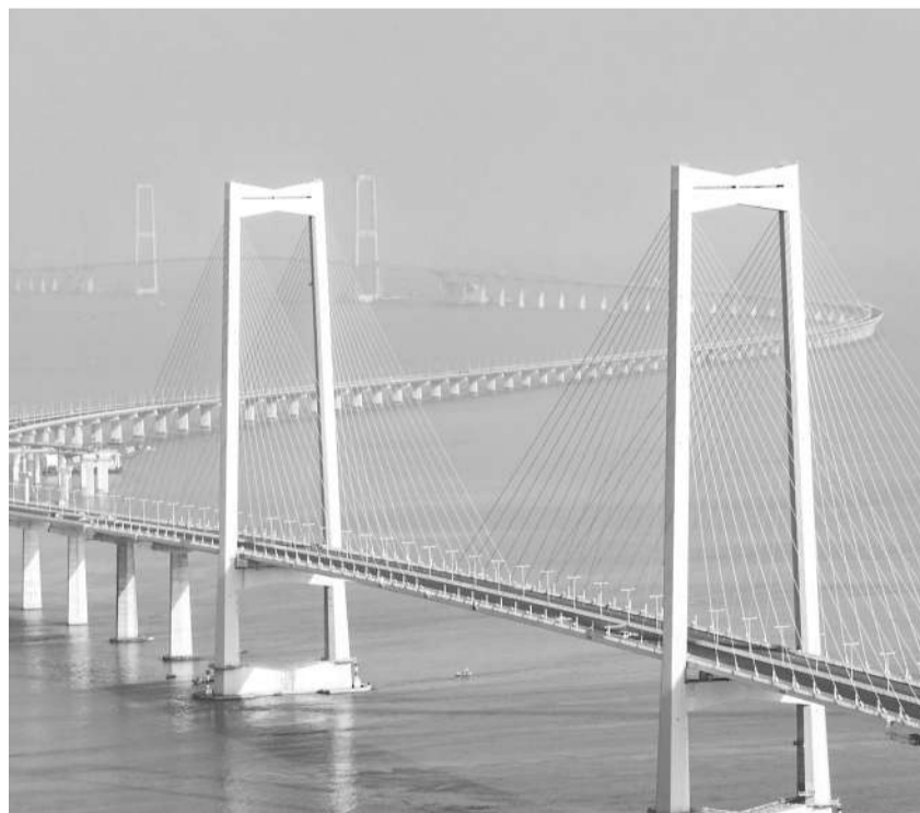
天堑通途,长虹卧波。11月28日,由广东省交通集团建设、中交二航局等单位承建的国家重大工程——深中通道主线全部贯通,项目建设取得重要进展,距离建成通车更近一步。
