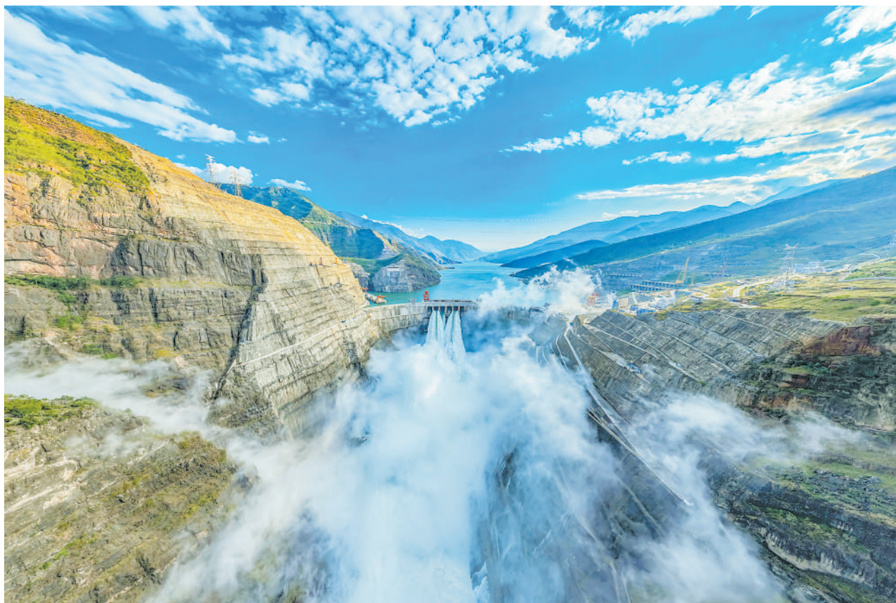
白鹤滩水电站全景图。
