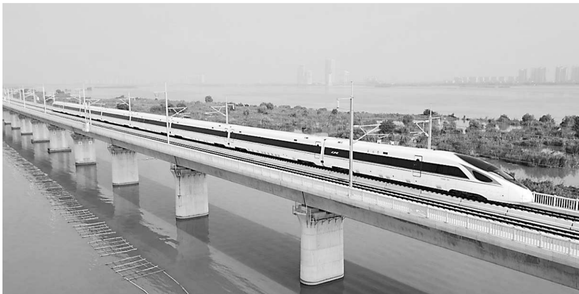
试验列车通过沪宁沿江高铁常州特大桥溧湖段。 陈苏青摄
