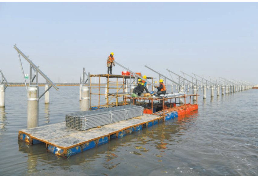
新年伊始,建设中的天津市2023年部分重点项目现场塔吊林立、机器轰鸣,建设者们用十足的干劲儿为经济高质量发展注入热活力。左图 2月9日拍摄的天津南港乙烯项目建设施工现场(无人机照片)。右图 在天津滨海新区龙源海晶盐光互补项目建设现场,建设者在水面上安装光伏板结构组件(2月7日摄)。
