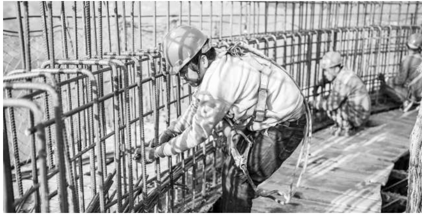
春节过后，贵州省全力推进重大项目复工复产，按下项目建设“加速键”。通过加强项目建设要素保障、补链延链强链等举措，贵州省确保2023年推进实施重大项目4000个以上，完成投资8000亿元，为新的一年高质量发展蓄势赋能。左图 工人在盘江新光燃煤发电项目现场施工（2月1日摄）。右图 工人在六安高速花江峡谷大桥主塔上施工（1月31日摄）。
